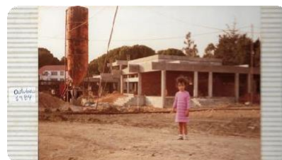
Figura A1 – Construção da Escola-Sede
